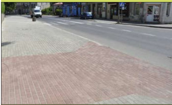
Ulica Jana Pawła II z nową nawierzchnią na chodniku.
