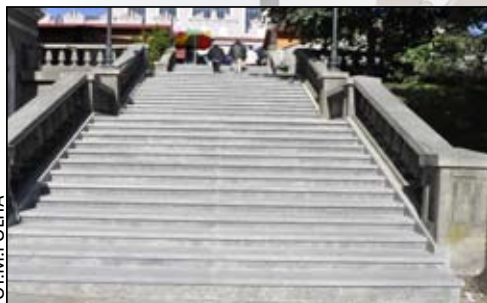
Wyremontowane schody prowadzące na halę targową.
