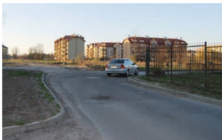
Odcinek drogi łączący ul. Konfederacką z ul. Skarbowskiego (za parkiem) zostanie wybudowany od podstaw.
