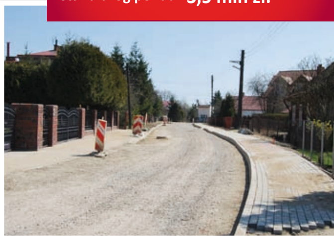
Ulica Zduńska w trakcie realizacji.
