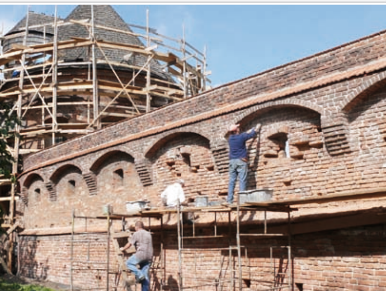
200 tys. - remont murów i baszt opactwa benedyktyńskiego (etap I)
