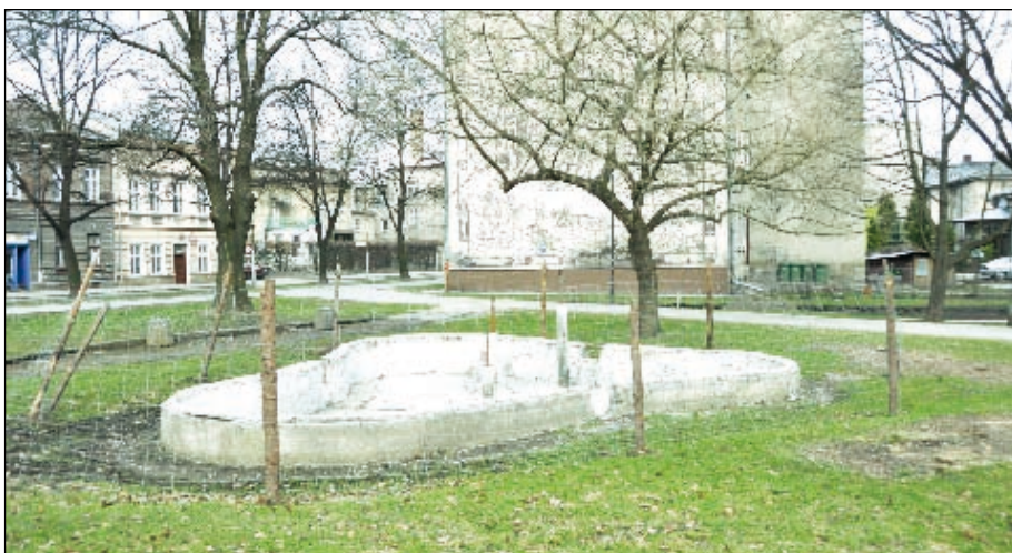
Prace w parku przy ulicy Bałki Puzon ruszyły już pełną parą.
