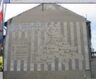
Widok przed remontem.
