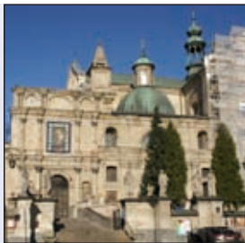
Widok przed remontem.
