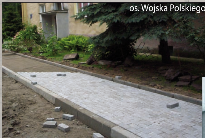
W trakcie prac.
