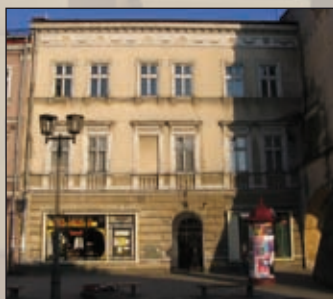
Widok przed remontem.
