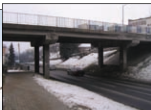
Widok przed remontem.
